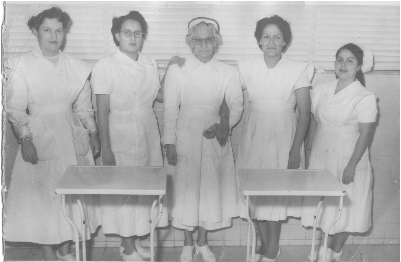
Enfermeras de la Fundidora de Monterrey
