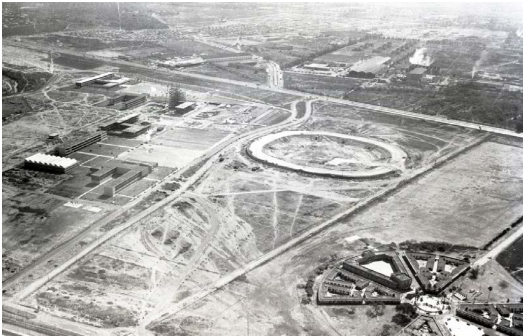
Ciudad Universitaria en proceso de construcción, ca. 1960. Fuente: CDAH-UANL.
