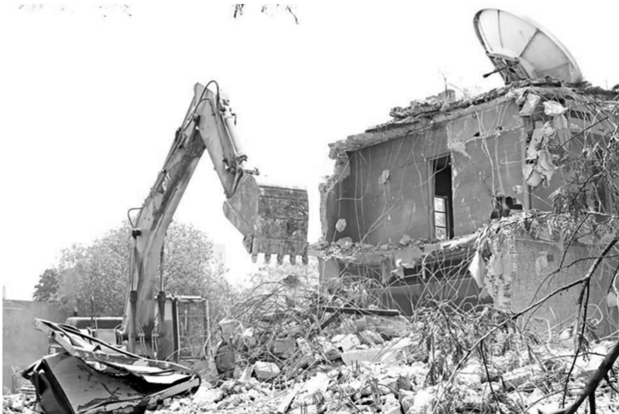
En la capital del estado es común la destrucción de patrimonio tangible, como la arquitectura. En la imagen, demolición de una casona en la colonia María Luisa en 2019. Fuente: Grupo Reforma.
