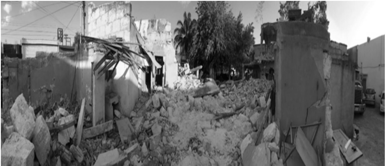
Demolición en la calle Diego de Montemayor, centro de Monterrey. Fuente: Selene Velázquez/La zona sucia.
