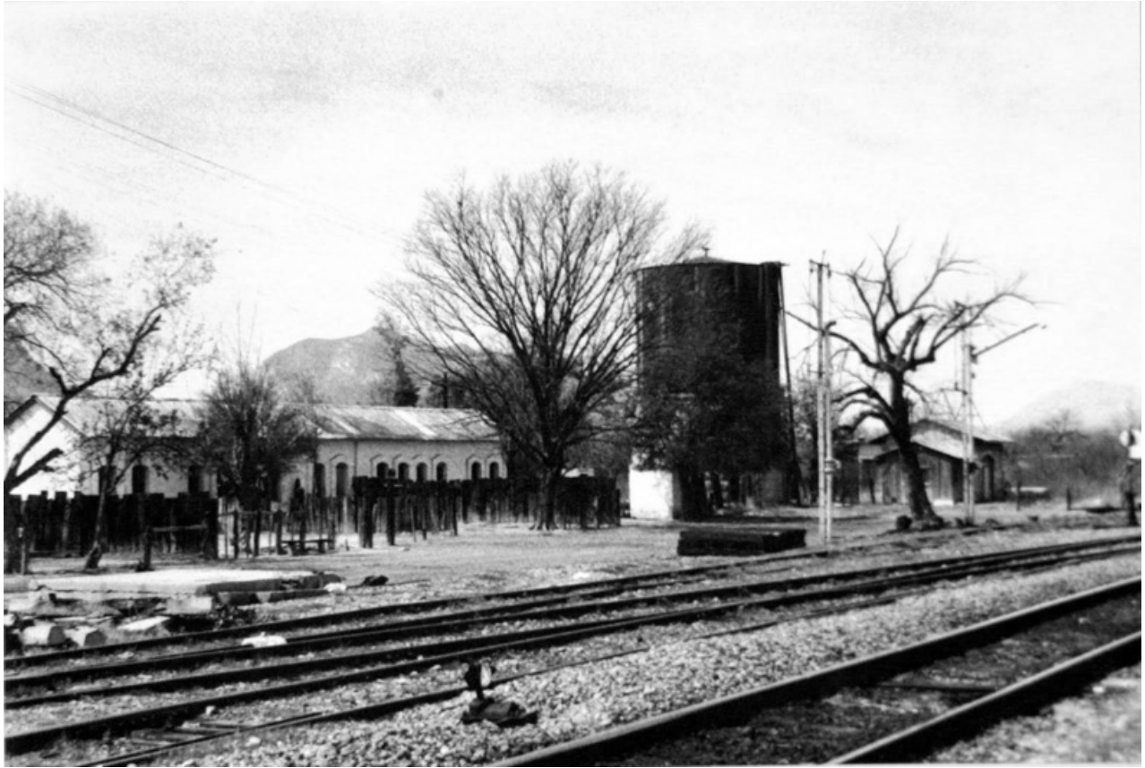
Tanque de agua en la estación del Ferrocarril
