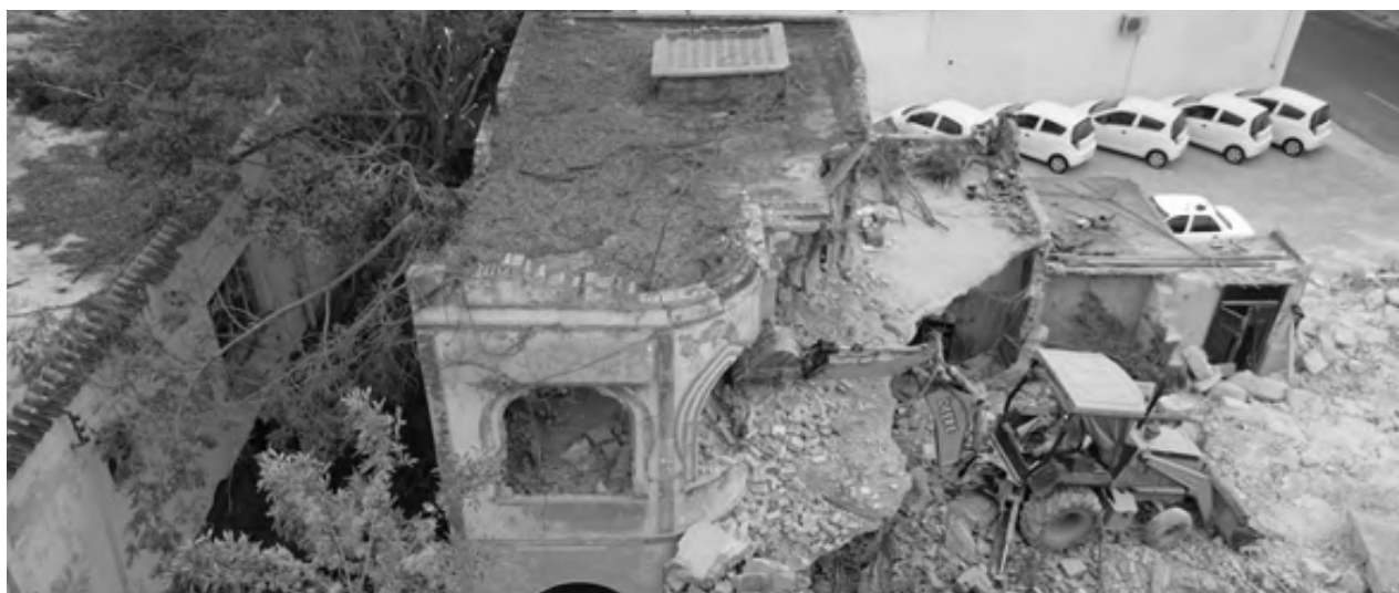
Vulnerabilidad del patrimonio edificado. Fuente: La zona sucia.
