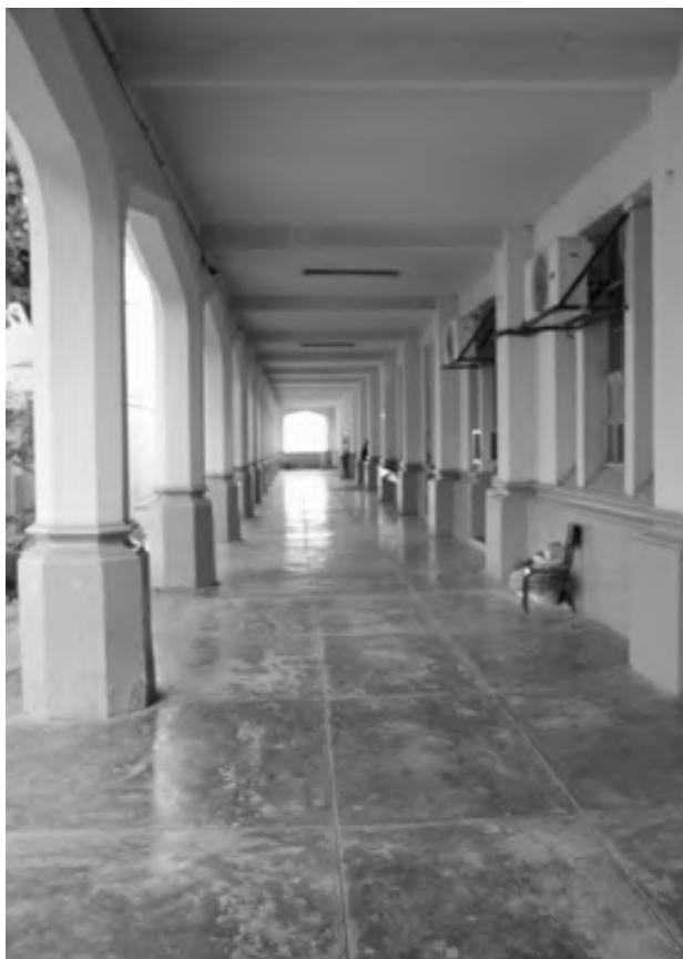
Pasillo lateral derecho donde se distribuyen las naves industriales de electricidad y mecánica.
