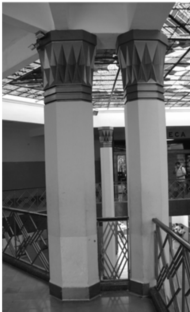
Vestíbulo del edificio, 2021. Fuente: Preparatoria Núm. 3.
