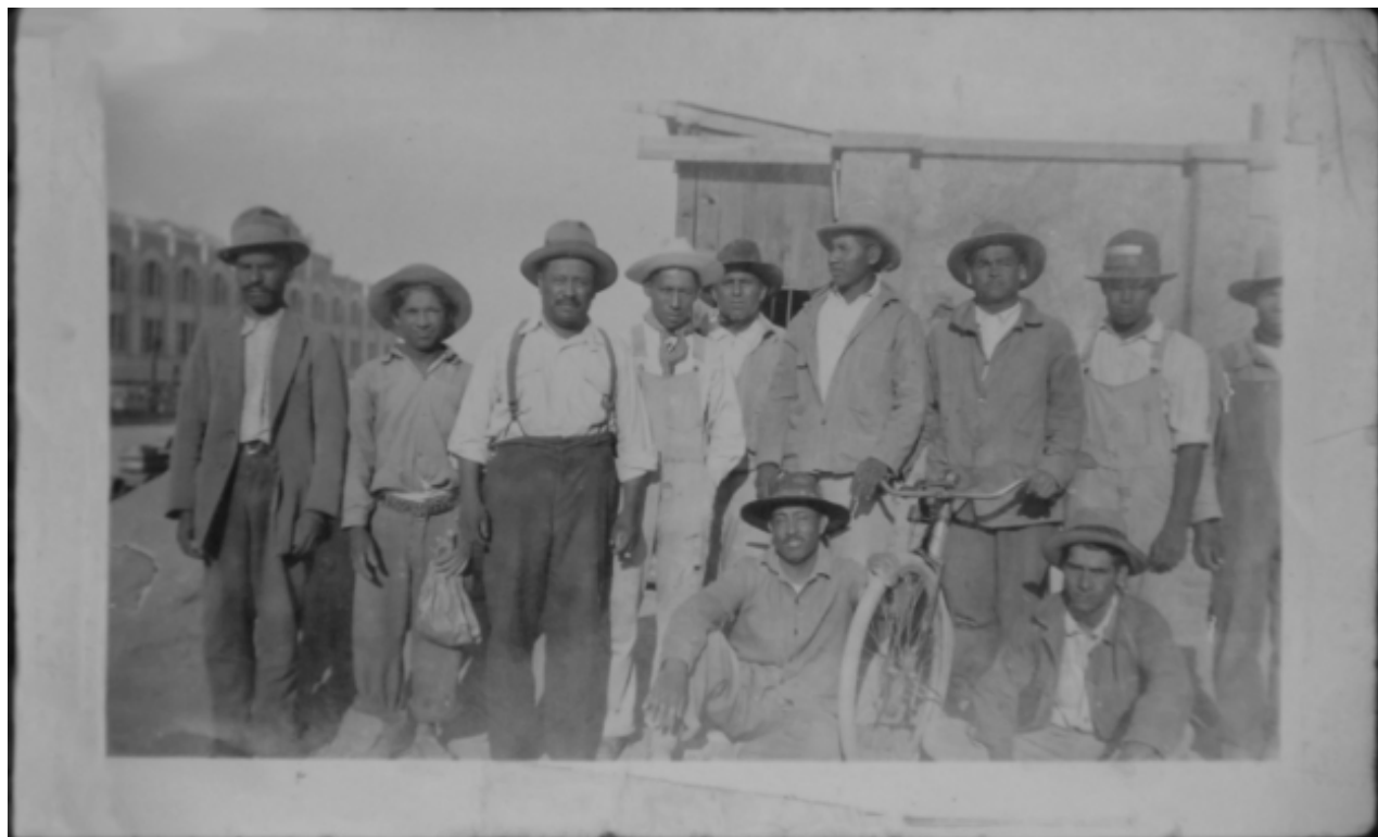
Figura 1. Fotografía de los albañiles que construyeron la estación de gasolina de la esquina de Félix U. Gómez y Calzada Madero, frente a la Escuela Industrial "Álvaro Obregón" (ca. 1931). Facilitada por Juan Ruiz Anguiano.
