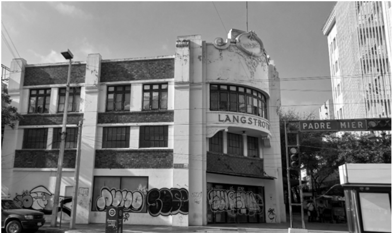
Casa Langstroth, en el centro de Monterrey, se encuentra en peligro de derrumbe por interés inmobiliario.
